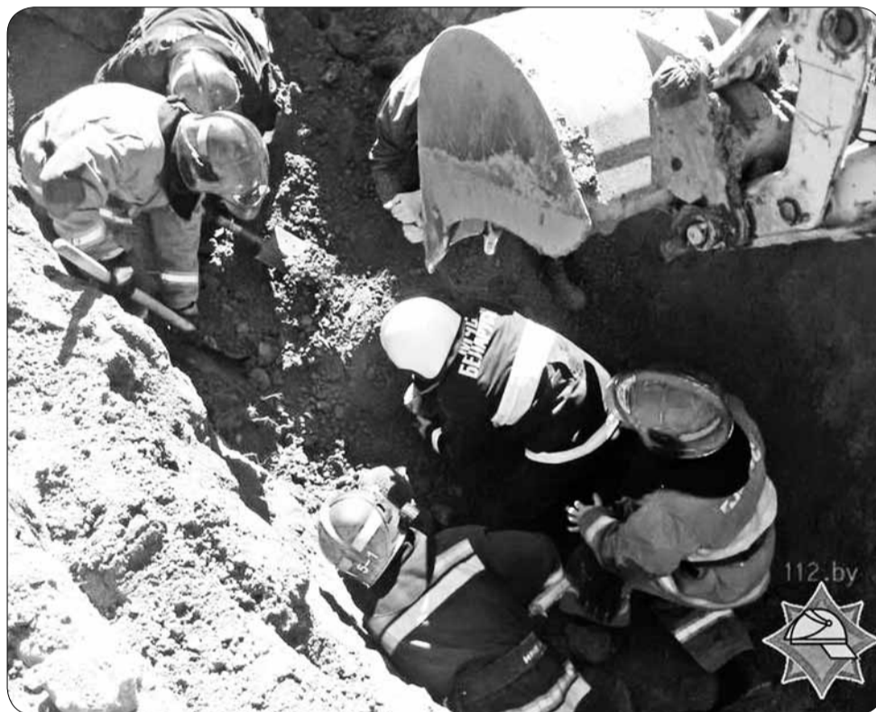
Трагедия произошла, когда бригада специализированной передвижной механизированной колонны укладывала канализационные трубы. ФОТО: МЧС.
